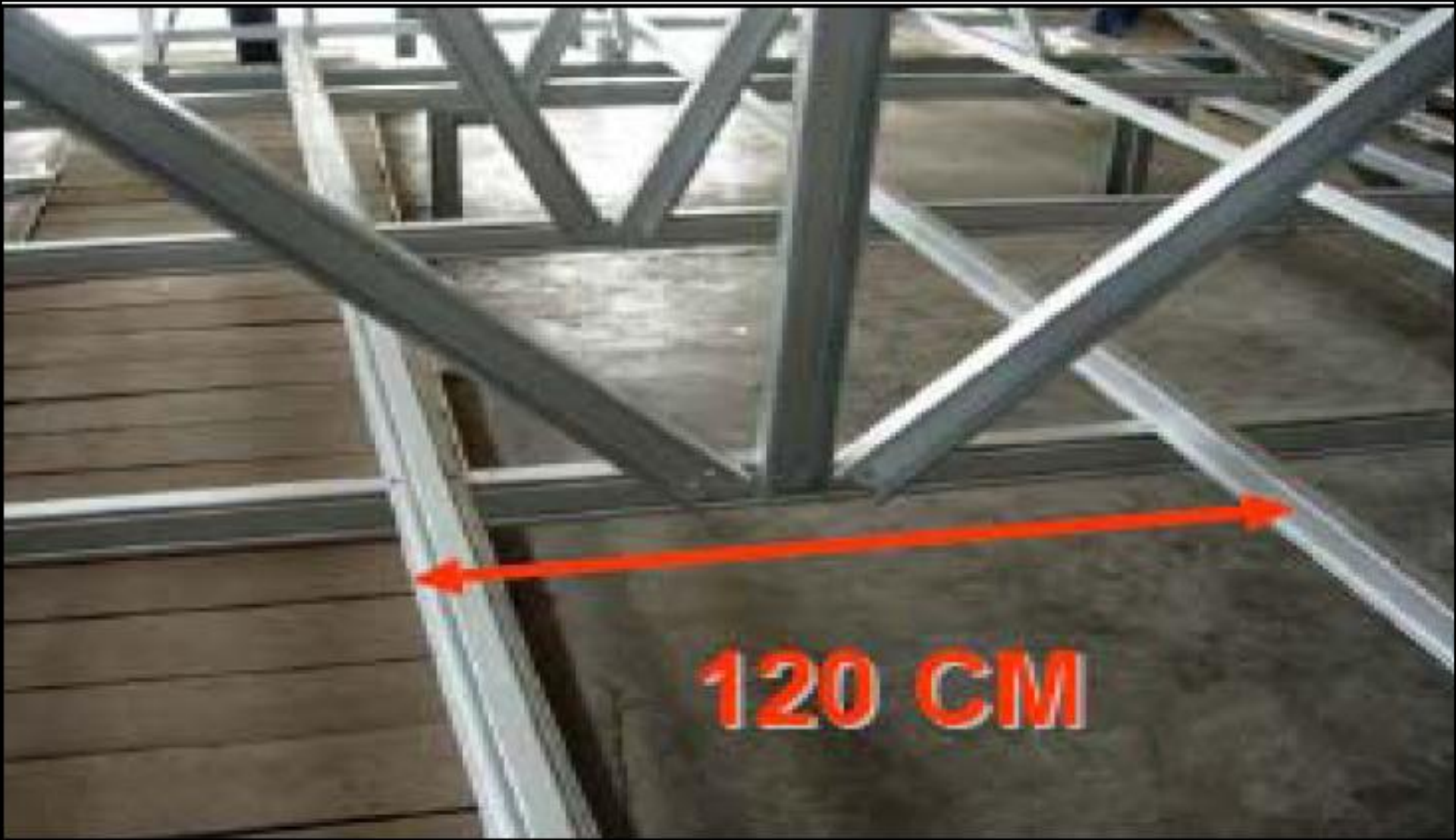
Pemasangan ceiling battens
