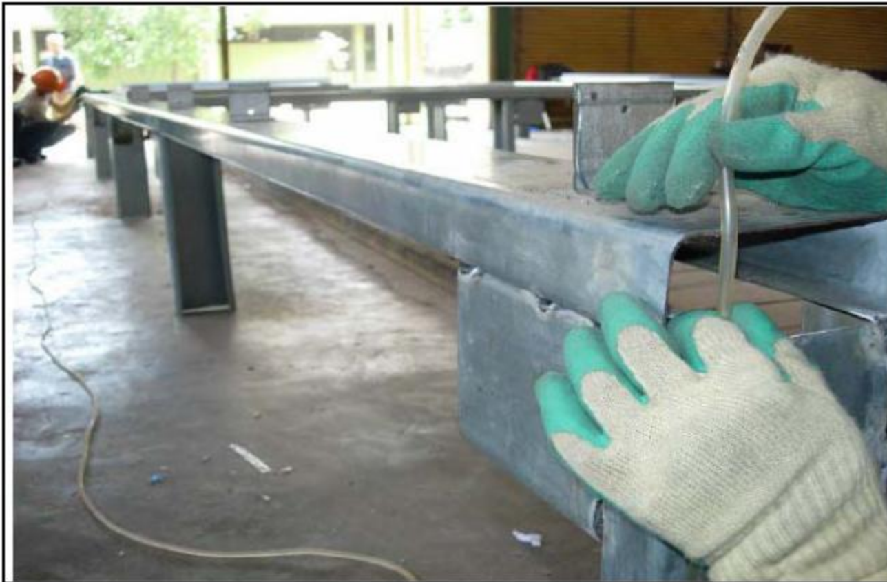
Kontrol siku dan leveling ring balok
