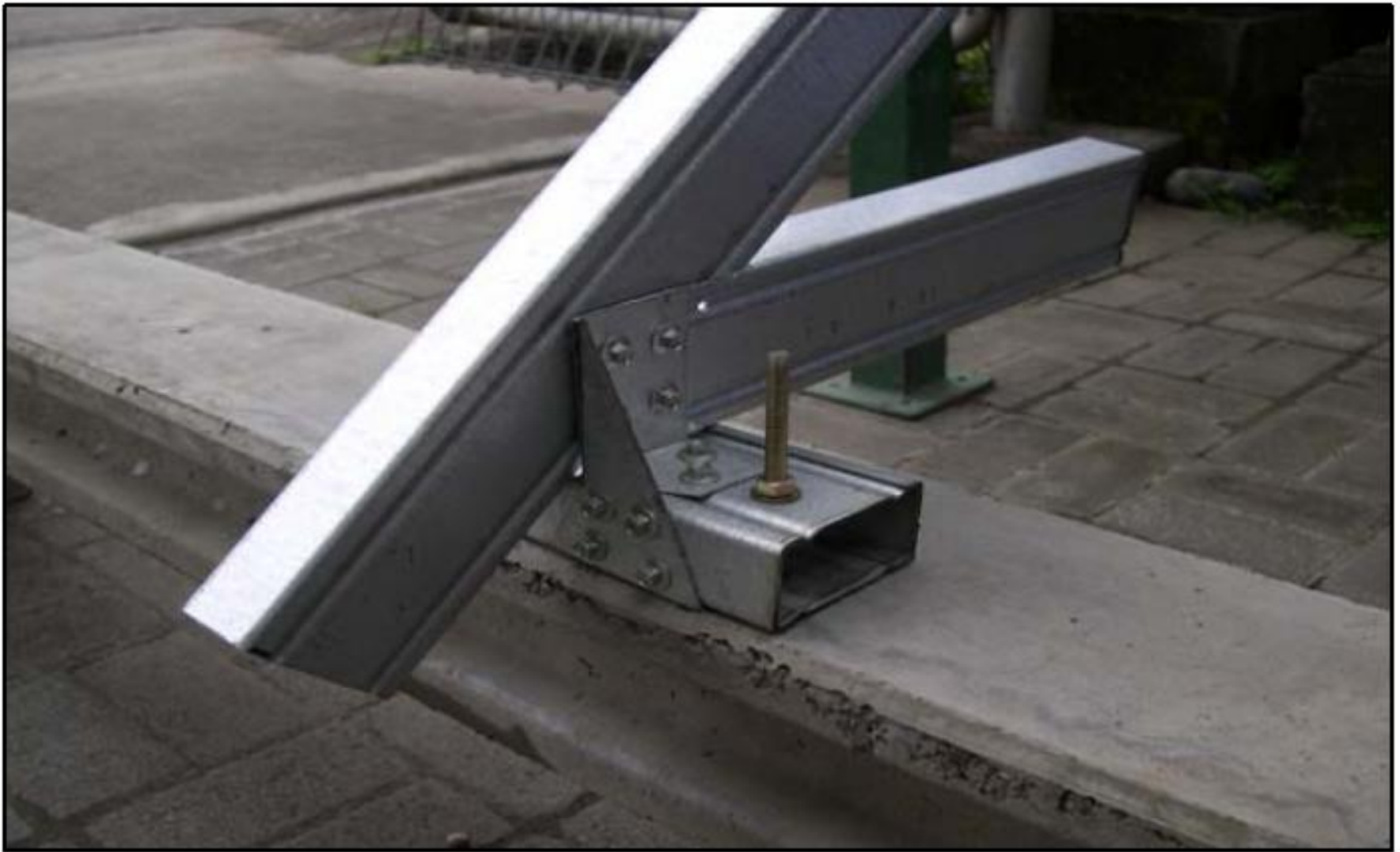
Contoh sistem tumpuan Wall-Plate Kuda-kuda ditumpukan pada boxed C75.100 , diikat dengan grip segitiga
